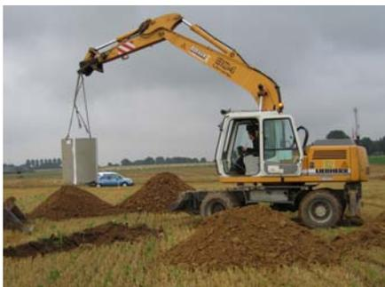
**Photo 4. Creusement de la tranchée entre le lysimètre et la chambre de visite**
